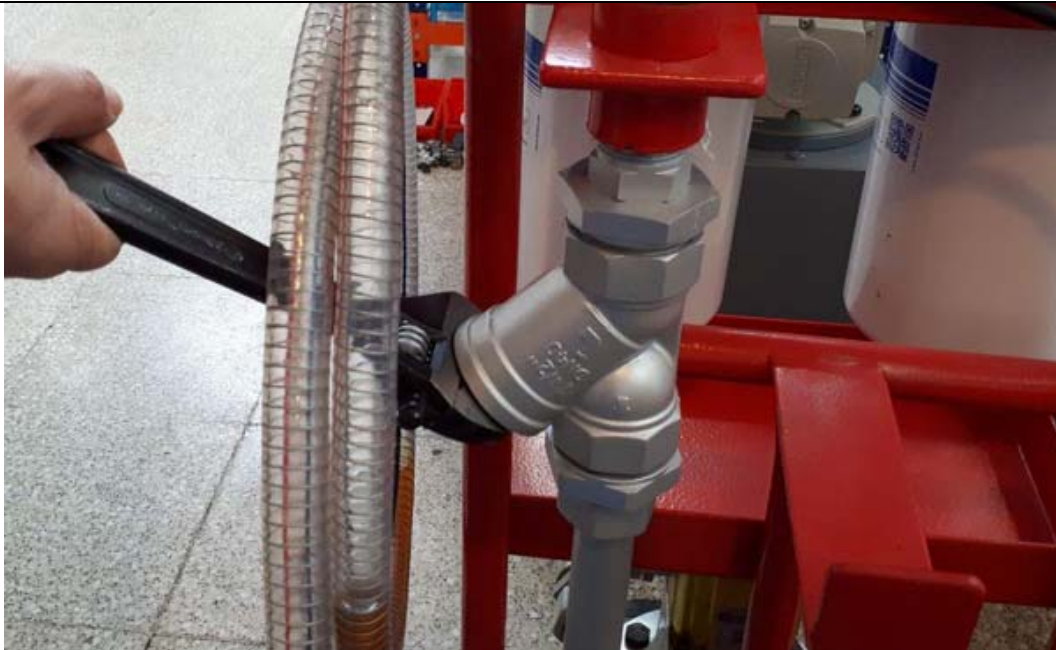
تمیز کاری صافی ورودی پمپ
